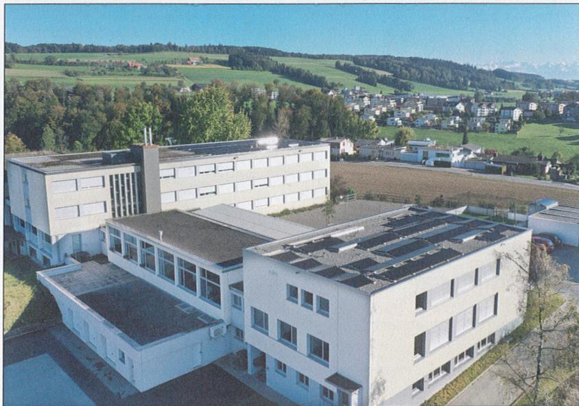
***An sonnigen Tagen liefert die Photovoltaikanlage eine Strommenge von bis zu 54.75 KWpeak.***
