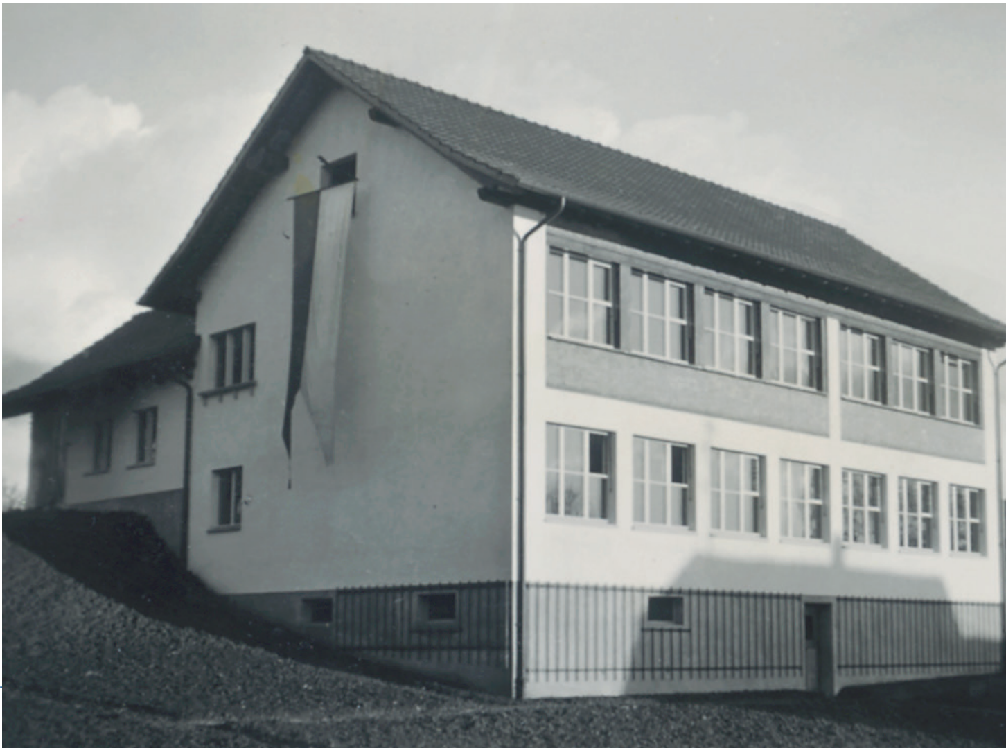
Neues Schulhaus, 1950 (Abb. 20)
