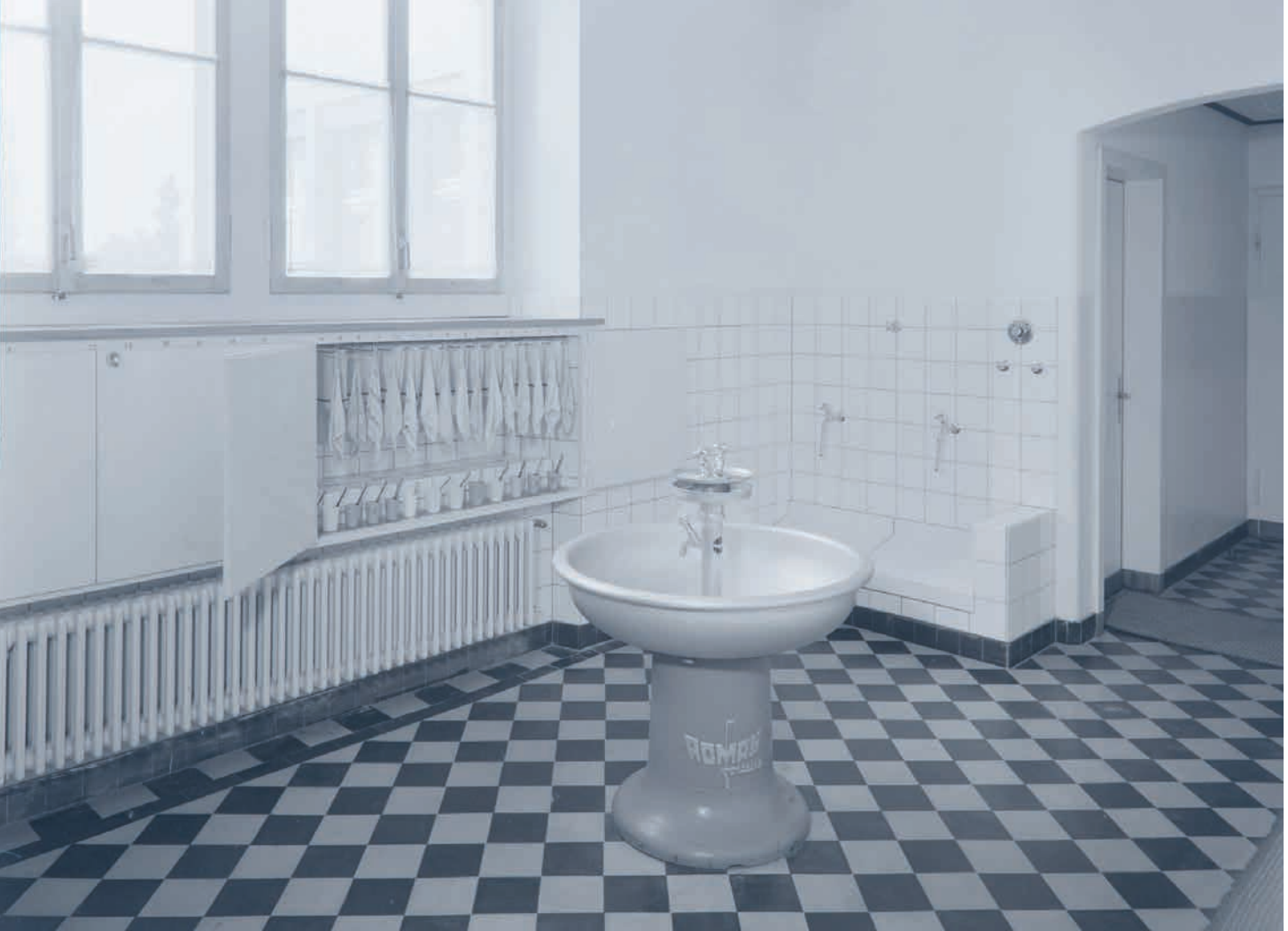
Waschraum nach dem Umbau, 1952 (Abb. 17)
