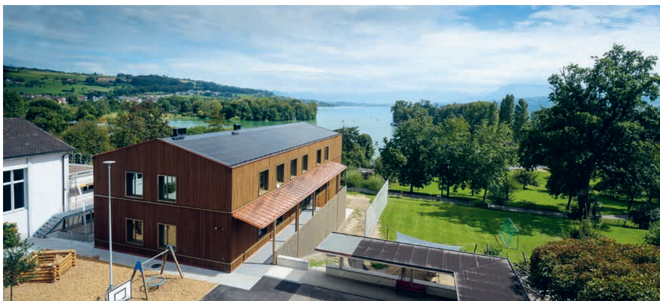
Neues Mehrzweckgebäude auf dem Gelände des Stammhauses Mariazell, 2020 (Abb. 40)
